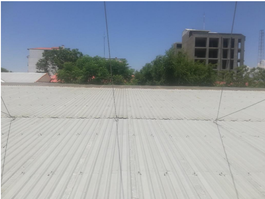
Vista panorámica de la cubierta
